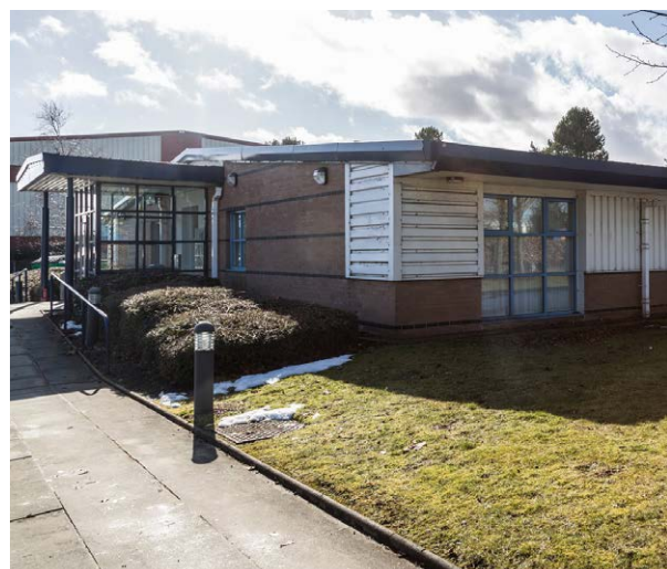
Les locaux d'Apex à Loanhead
